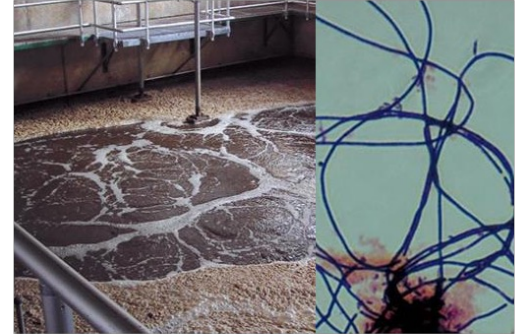
Schaumbildung auf Kläranlagen
